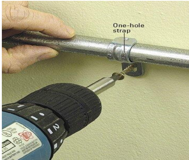
Figure 37: Step 5 Anchor Conduit
